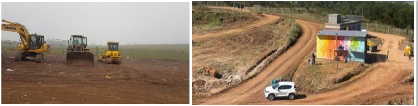
Bontebok Landfill Site
