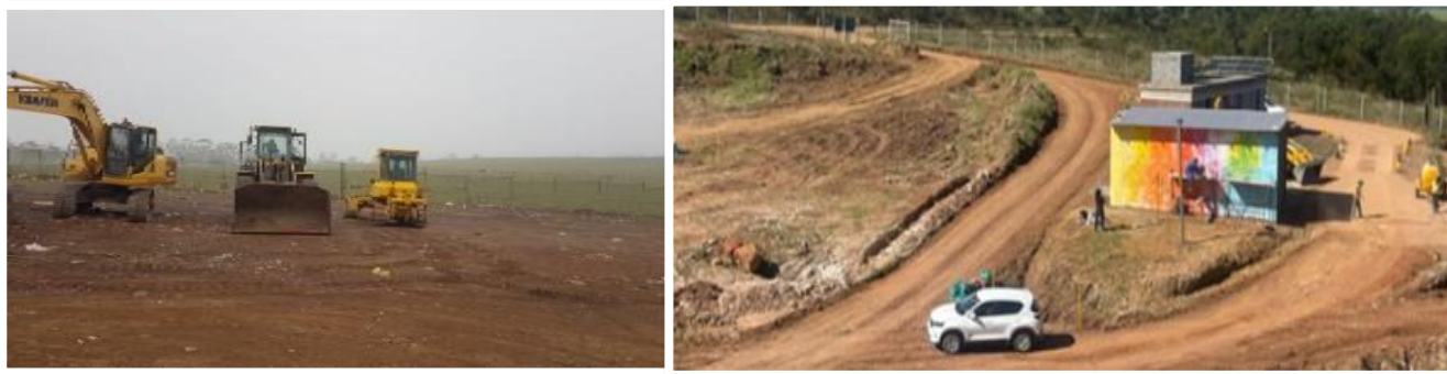
Bontebok Landfill Site
